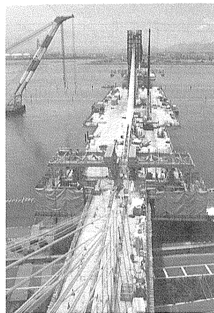
写真-4 サイド断面張出し状況
