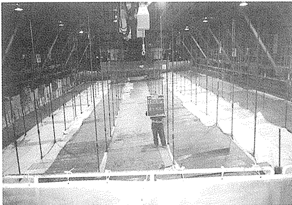
写真-11 断熱保温養生状況
