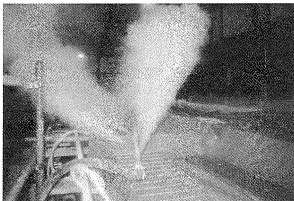
写真-7 蒸気発生状況
