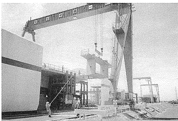
写真-4 60tf 橋形クレーン
