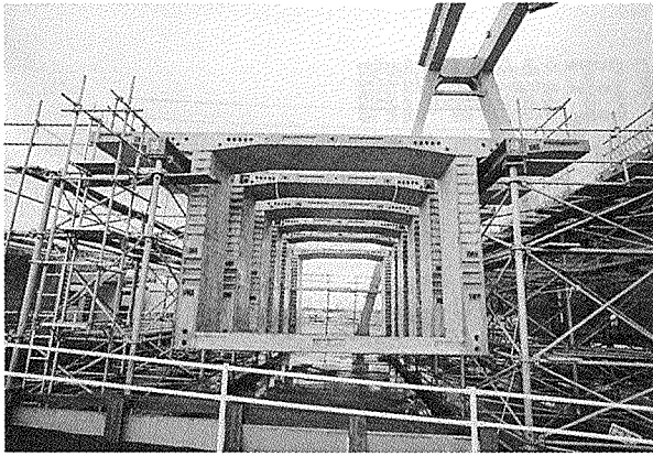
写真-8 セグメント仮置き状況 (桁高高)
