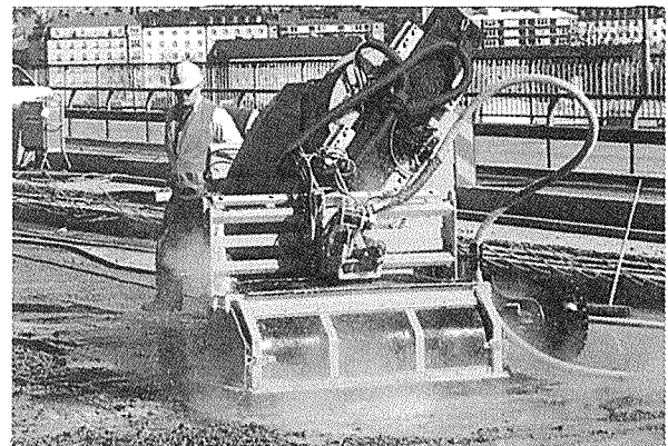
写真-2 自走式はつりロボット
