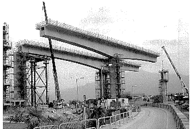
写真-9 カンチレバー架設(1)
