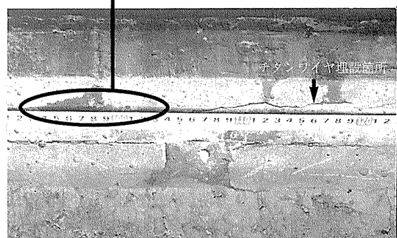
写真-3 チタンワイヤ方式の外観目視調査
