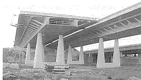
写真-12 レック橋（側径間施工済）
