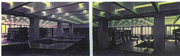
写真 - 31 図書室：リブの中に照明ボックスを組み込む
