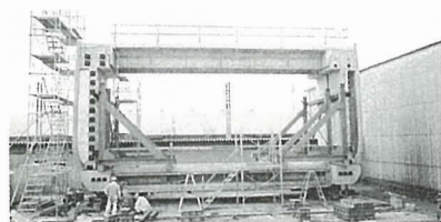
写真-5 実大実験状況 “プレキャストの箱を組み立てる”
