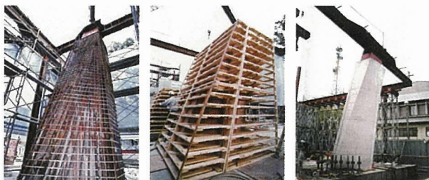
写真 - 28 配筋・型枠 (3次元 CAD のデータを用いて加工)
