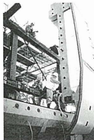
写真-6 壁版建て方
