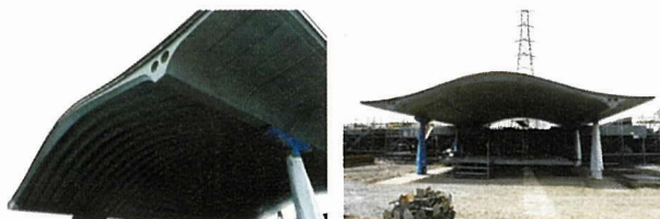
写真 - 22 圧着して一体化し、鋳鋼柱で支える
