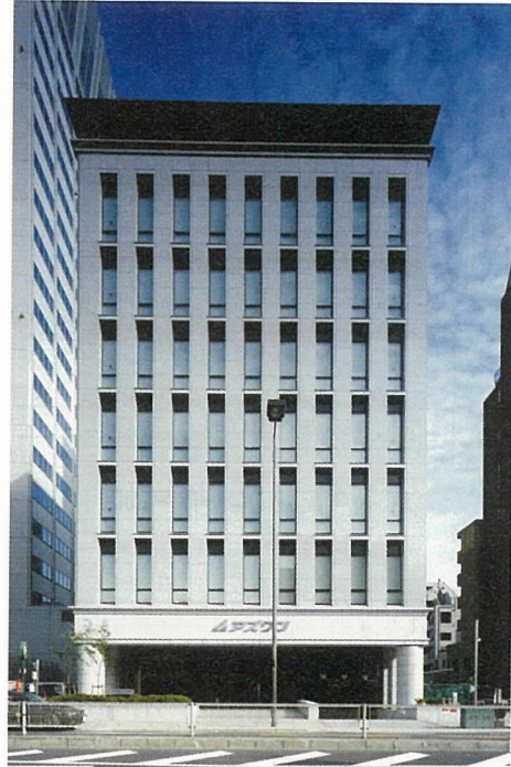
写真 - 1 建物外観
