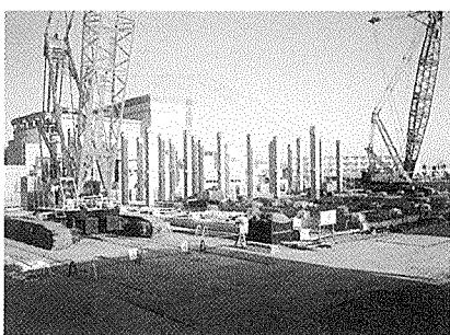
④ 柱建方 (300t クレーン 2 基)
