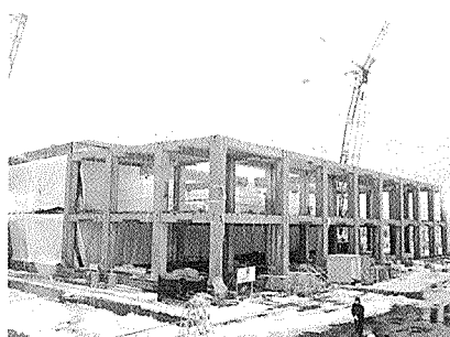
⑥ 最上階梁架設 (根雪が積もり始める)
