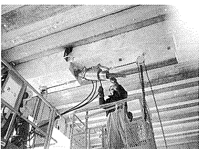
⑦ 梁二次ケーブルの緊張
