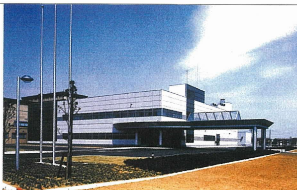
写真 - 1 建物全景
