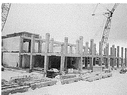
⑤ 柱, 梁架設 (2 工区に分け, 奥の工区はシート養生を行いグラウト充填施工中)
