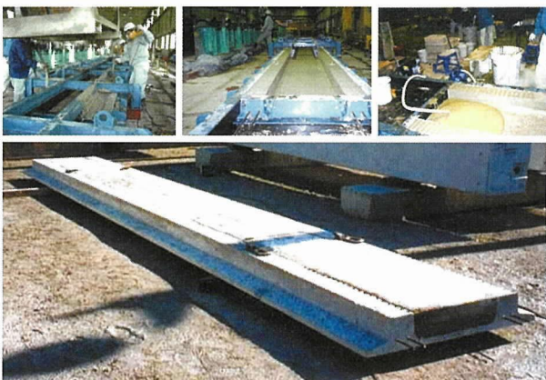
写真 - 3 実大製造実験
