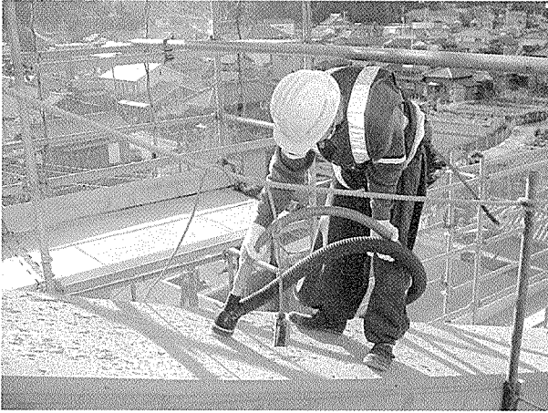
写真 - 13 バキューム・ブラスト工法による表面処理状況
