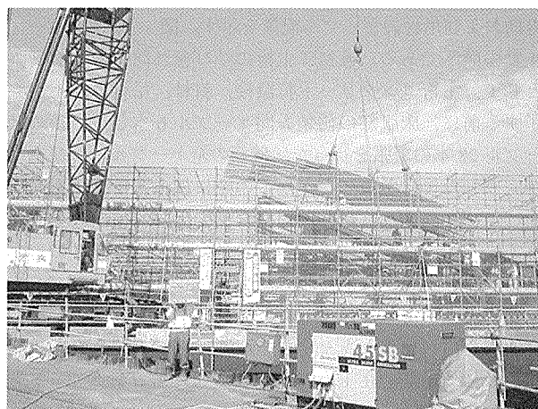
写真-6 クレーンによる鉄筋ブロックの架設
