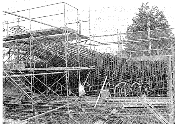
写真-1 主桁・斜材接合部の配筋状況
