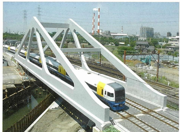
写真 - 17 使用開始後の姉ヶ崎川橋梁
