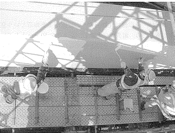
写真 - 14 ローラーによる塗料の塗布状況
