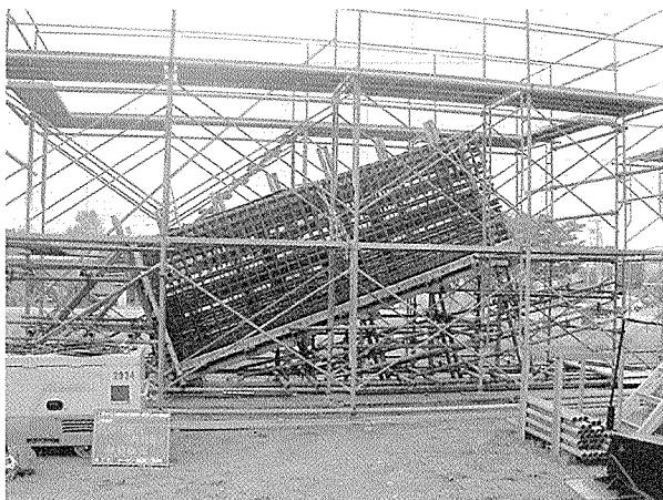
写真 - 3 斜材実物大試験体の配筋状況
