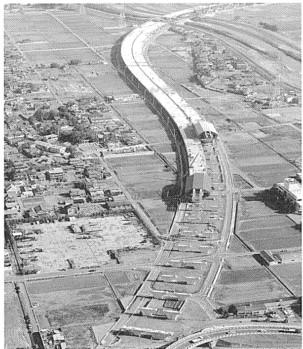
写真 - 3 現場状況
