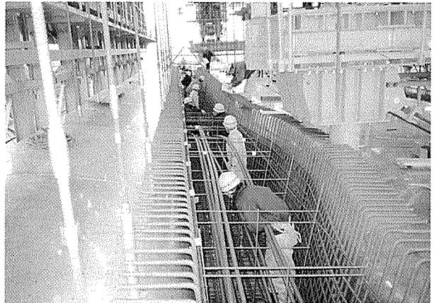
写真-7 配筋・配管状況
