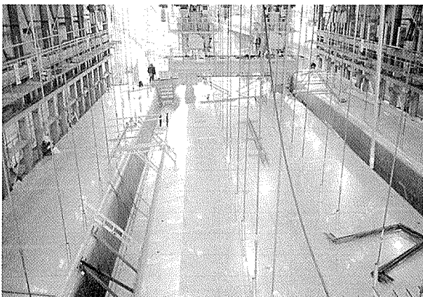
写真-6 型枠組立
