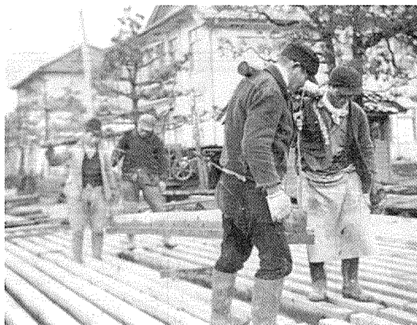
写真 - 2 長生橋の施工状況
