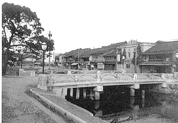
写真 - 1 建設当時の長生橋
