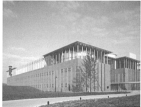
写真-3 免震構造を使ったプレキャストPC造建物 10)
