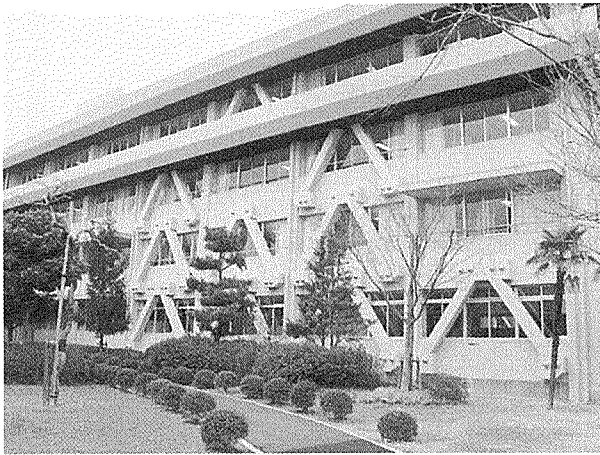
写真 - 4 PC 造による耐震補強事例 12)
