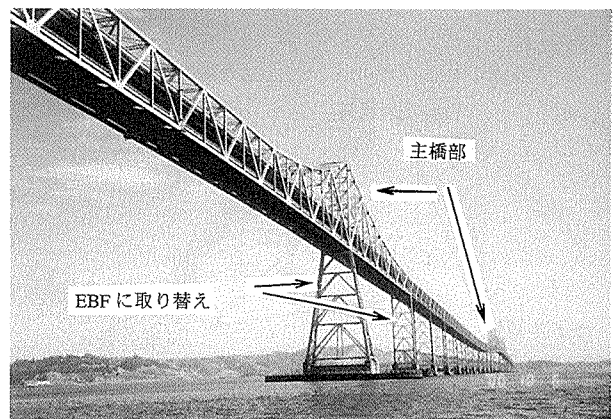
図 - 10 Richmond-San Rafael 橋
