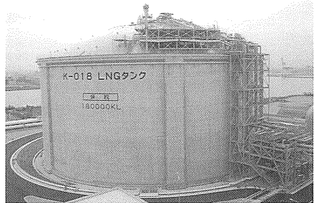
写真 - 1 PCLNG 貯槽 (容量 18 万 m 3 ) (大阪ガス(株)泉北製造所第二工場)
