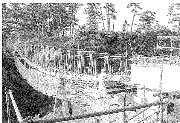
写真 - 3 下床版セグメントの架設完了
