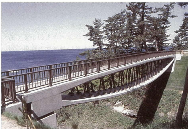
写真 - 1 巖門園地園路橋の全景
