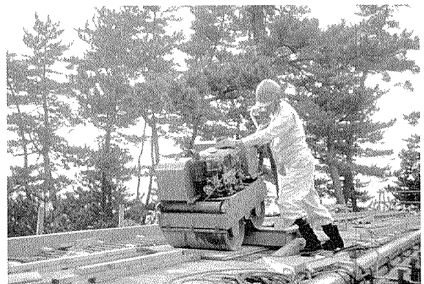
写真 - 7 振動試験の状況
