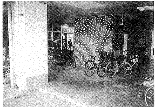
写真-2 耐震改修例（ピロティ部分）
