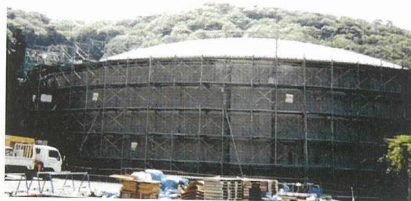
写真 - 3 建設中の PC タンク
