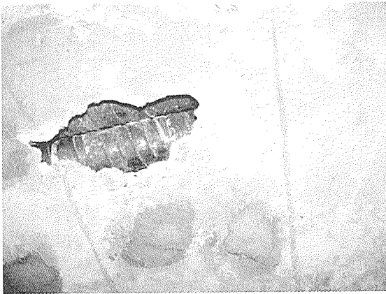
写真-1 不適切なケーブル配置により生じたジャンカ
