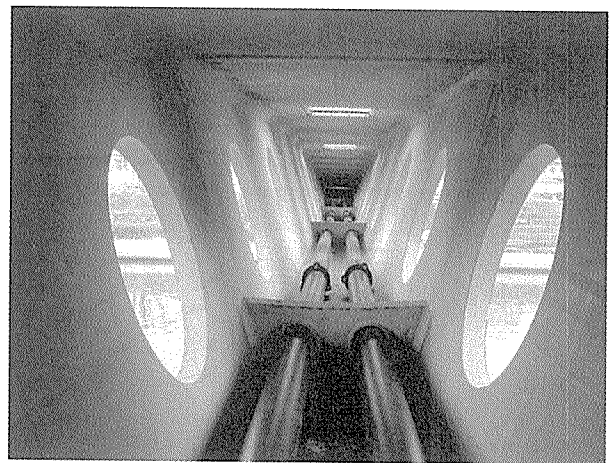
写真 - 7 桁内 PC 鋼材配置状況
