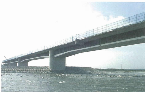
写真 - 8 本体完成状況
