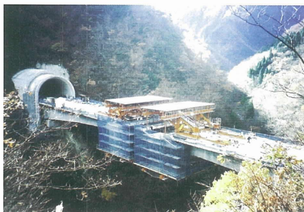
写真-1 東海北陸自動車道加須良橋(施工時)
