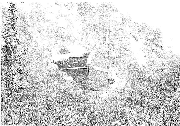
写真-4 冬期仮囲い
