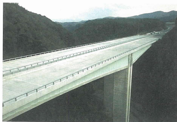
写真-1 前谷橋（波形鋼板ウェブ橋）
