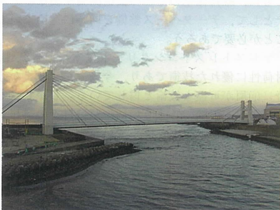
写真-1 完成写真
