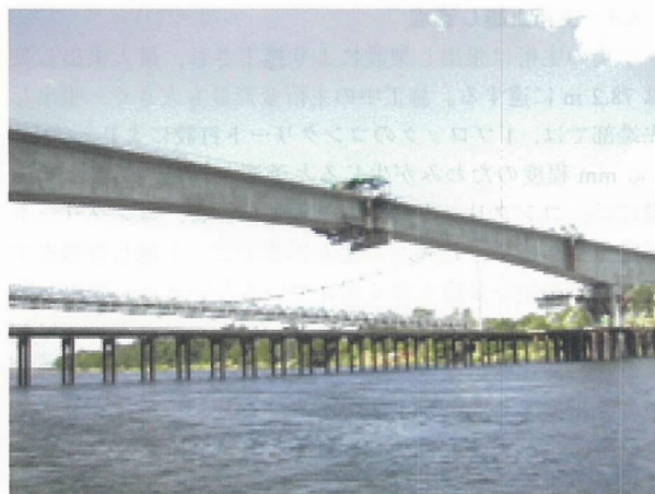
写真-4 中央径間閉合部の施工
