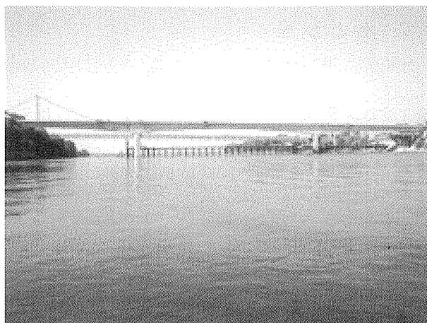
写真-1 全景写真
