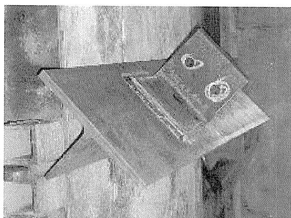
写真-3 アングルジベルの構造 24)
