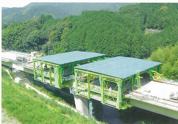
写真-1 移動型枠支保工による PC 厚肉床版施工 (提供：第二東名高速道路藁科川橋工事)
