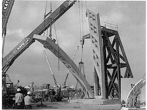
写真-5 実物大モックアップ建て方状況
