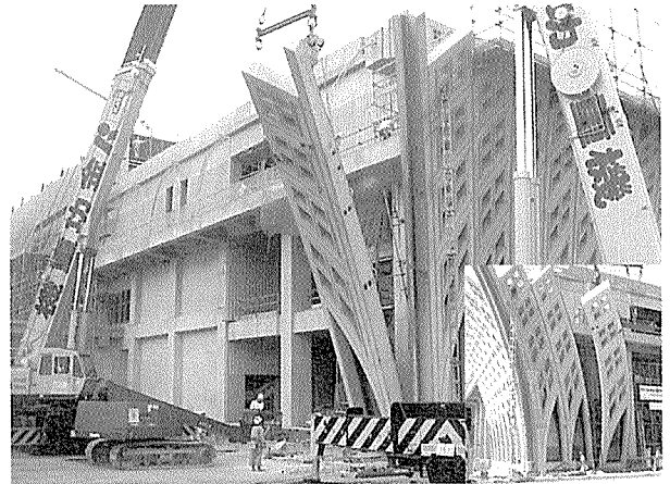
写真 - 11 建て方状況
