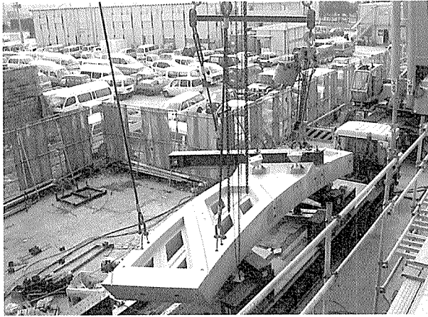
写真 - 10 地切状況
