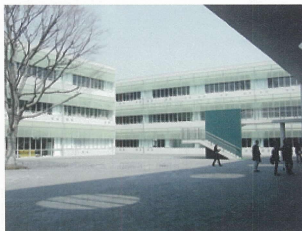
写真-1 建物外観
