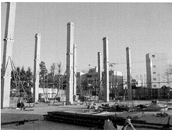
写真-4 施工時外観(教室棟柱建て方時)
