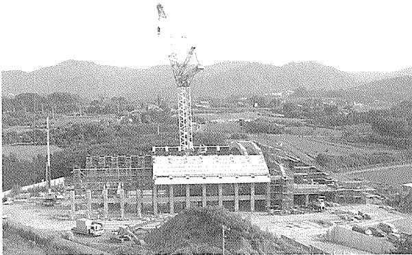
c) 架設状況 - 1
