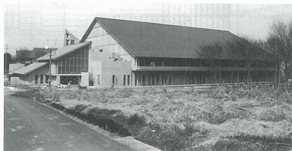
写真-2 建物外観
