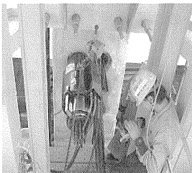
梁緊張状況 (300 ton ジャッキ使用)
