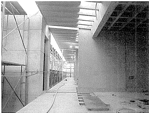
写真-3 共用廊下とEVシャフト
