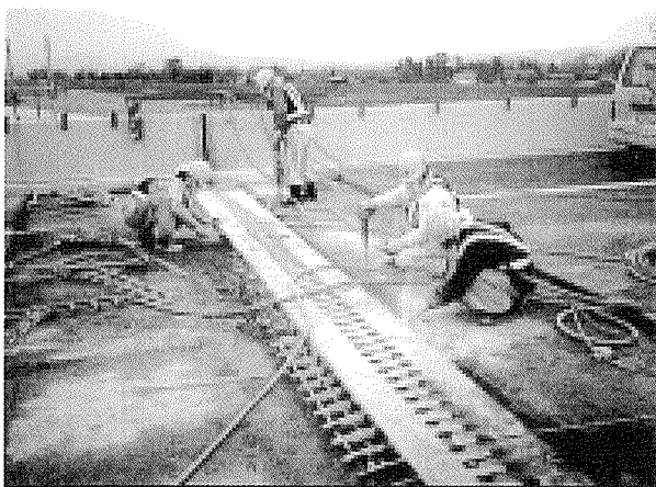
写真 - 3 伸縮装置の撤去状況
