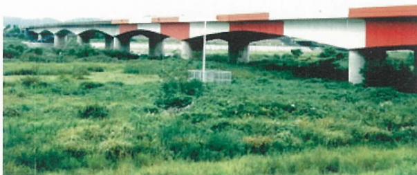
写真 - 1 既設橋梁の全景
