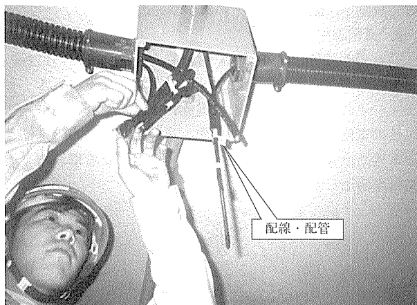
写真 - 3 配線・配管
