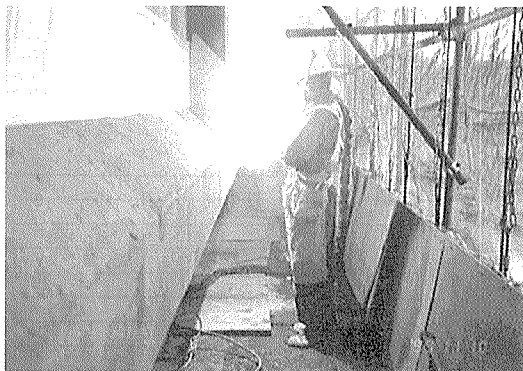
写真 - 5 電気防食（チタン溶射方式）
