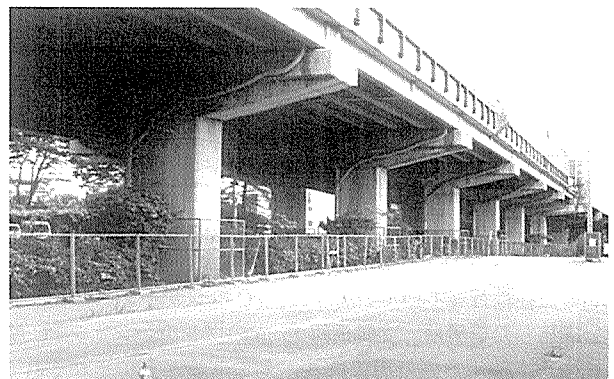
写真-1 対象とした高架橋
