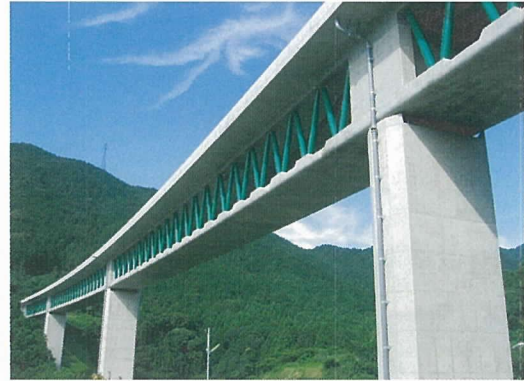
写真-1 木ノ川高架橋
