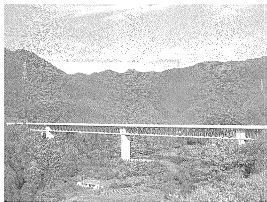
写真-5 下流から見た木ノ川高架橋
