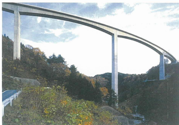
写真-1 鷲見橋（最高橋脚高さ 118 m）
