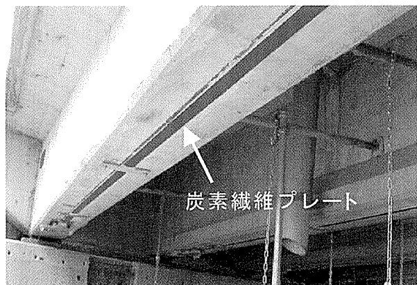
写真-2 炭素繊維プレートを用いてプレストレスを導入した補強例
