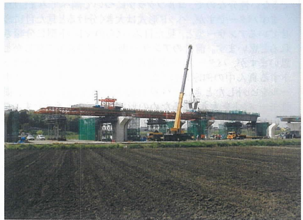
写真 - 1 上和会高架橋の架設状況
