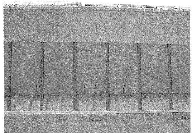
写真 - 5 張出し床版下面
