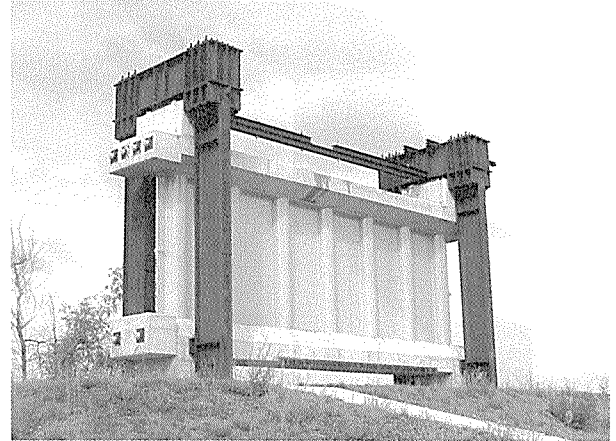
写真 - 4 鋼製ウェブ供試体
