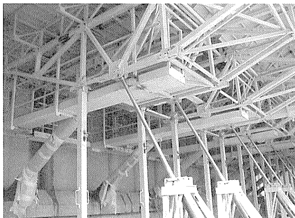
写真 - 3 張出し床版部(鋼製ストラットおよび上床版型枠) Photo par Jacques Mossot(pour www.structurae.de)
