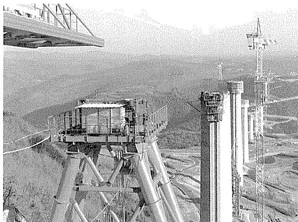
写真 - 3 橋脚施工状況（手前は仮設鋼製橋脚）
