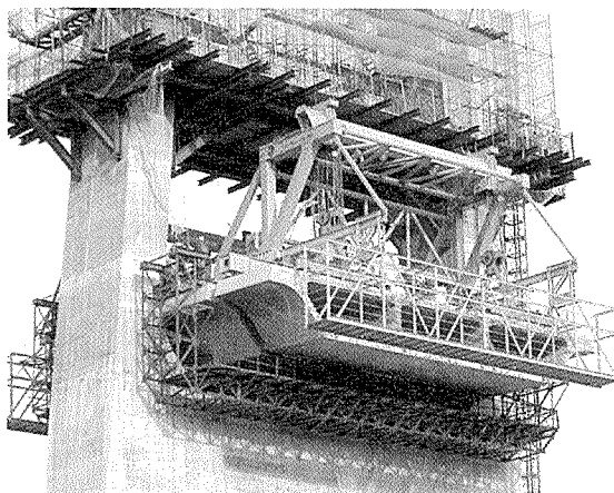
写真 - 4 基準セグメントの架設
