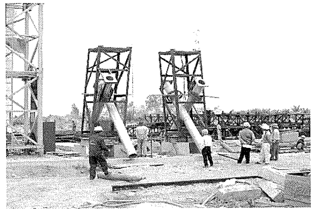
写真-7 主塔鉄骨の仮組み
