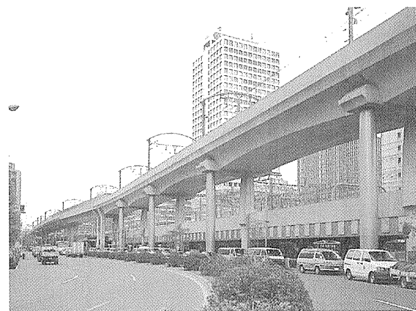
写真 - 7 中央線東京駅付近高架橋
