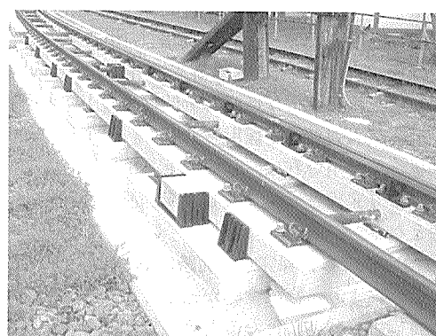
図 - 10 フローティング・ラダー軌道（防振材式）
