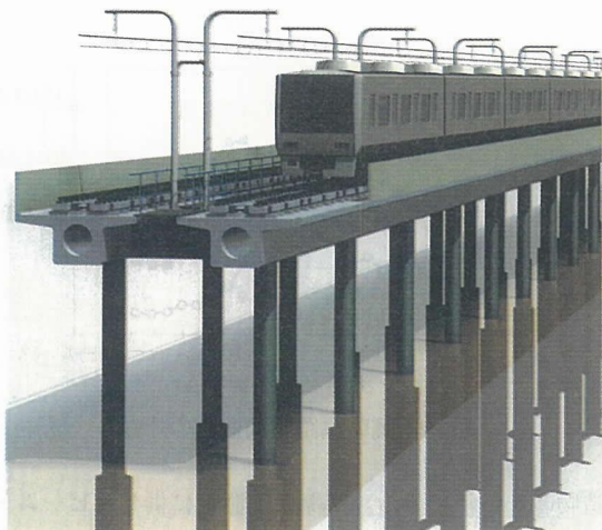
図-12 RC 軌道支持梁ラーメン高架
