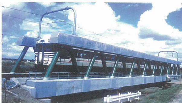
写真 - 1 完成した山倉川橋りょう
