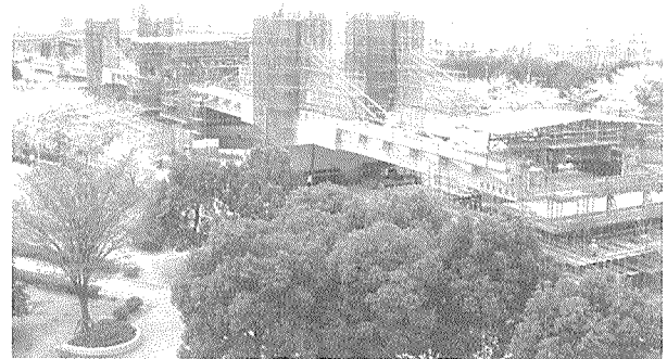
写真 - 1 張出し施工状況
