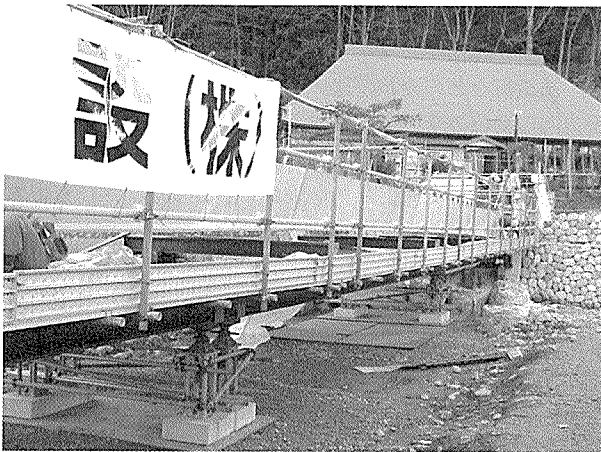
写真-7 四角支柱とH形鋼による支保工
